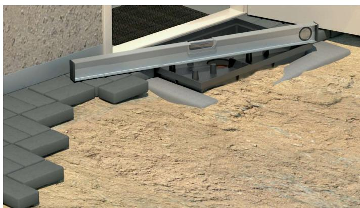
3. Проверить горизонтальность установки. При необходимости — скорректировать. Вокруг установленного поддона уложить плитку.
