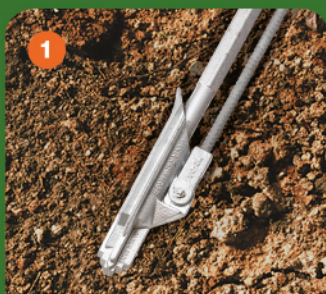
1 Погружаем анкер на заданную глубину
