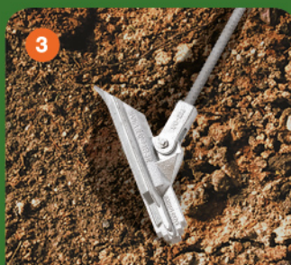
3 Натягиваем стержень до блокировки анкера
