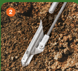
2 Вынимаем толкатель
