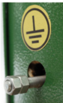
Рис. 4 Крепеж заземления
