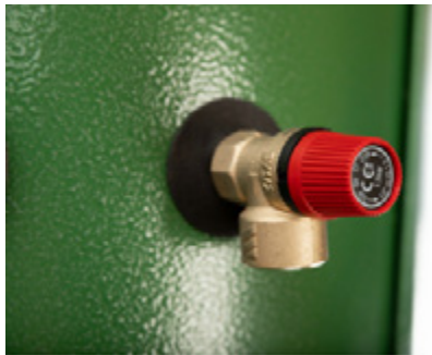
Рис. 18 Установка клапана безопасности
