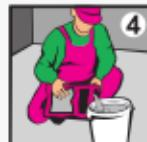
Для приготовления растворной смеси необходимо взять точно отмеренное количество чистой водопроводной воды комнатной температуры (на 1 кг сухой смеси 0,24-0,28 л воды, на 1 мешок 25 кг – 6,0-7,0 л воды).
