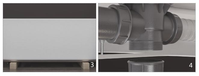
После подключения и снятия подставок ванну необходимо выровнять относительно уровня пола при помощи скрытых ножек, так, чтобы скрыть неровности пола и оставить небольшой зазор между полом и днищем ванны
