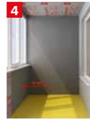
После дюбелирования производится нанесение базового штукатурного слоя с армированием щелочестойкой сеткой. Толщина нанесенного штукатурного слоя на плиты не менее 6 мм.
