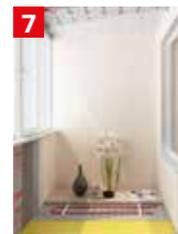
После высыхания базового слоя штукатурки стен и устройства теплого пола можно производить финишную отделку: покраску стен, приклеивание обоев, укладку финишного покрытия пола (плитка, ламинат и пр.).
