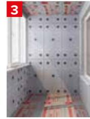
Через 24 часа после приклеивания плит теплоизоляции на стену и потолок необходимо дополнительно провести крепление плит фасадными дюбелями. Проверьте, чтобы их было не меньше 4 шт на одну полную плиту теплоизоляции.
