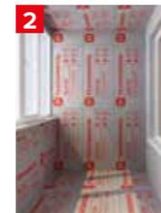
Перед приклеиванием гладких плит экструзионного пенополистирола на стены необходимо равномерно отфрезеровать их с помощью ножовки или металлической щетки.
