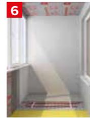
Для обеспечения равномерного прогрева, нагревательные элементы рекомендуется располагать в среднем слое стяжки или плиточного клея (при устройстве сборной стяжки) или укладывать на специальные подставки - «стульчики» перед укладкой цементно-песчаного раствора.
