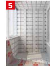
Перед монтажом финишного слоя (панелей МДФ, вагонки, пластиковых панелей) нужно организовать вентиляционный зазор, необходимый для прокладки коммуникаций (электрика, отопление, водоснабжение) без нарушения слоя пароизоляции с помощью контробрешетки из деревянных брусков. Толщина зазора не менее 30-40 мм.
