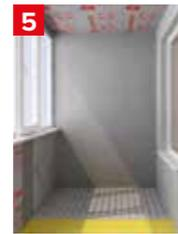
Армирование базового штукатурного слоя стен производится щелочестойкой фасадной сеткой, при этом сетка утапливается в середину базового штукатурного слоя.
