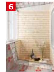
Далее выполняется финишная декоративная отделка стен и потолка с помощью пластиковых панелей, вагонки, ГКЛ листов. Так же можно сделать натяжной потолок.
