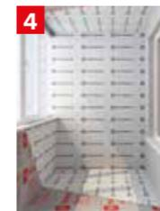
После того, как швы запенены, а излишки клей-пены удалены, необходимо смонтировать герметичный пароизоляционный слой. Швы пароизоляционной пленки должны быть проклеены с помощью специальной двусторонней клейкой ленты.
