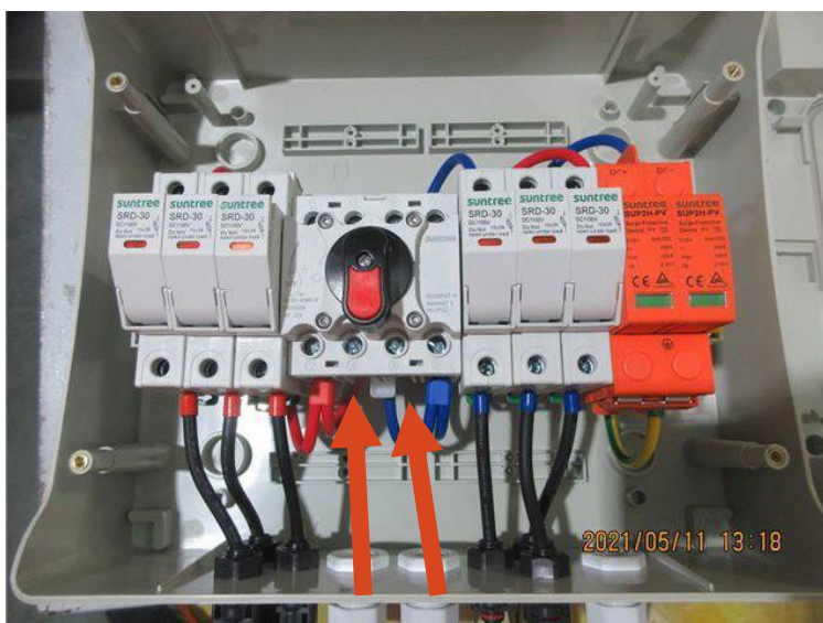
Рисунок 5.10 Внутреннее устройство PVBox.
