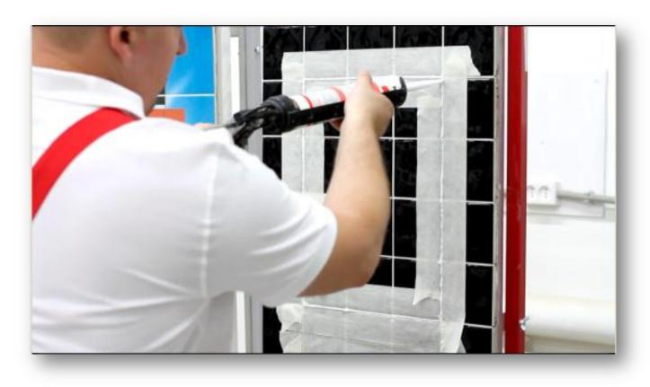
Уплотняем герметик, можно просто провести пальцем по периметру шва.
