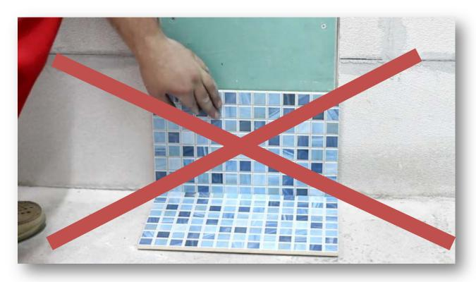
Неправильная укладка плитки ведёт к потере отделочных материалов, потере функционала люка, дополнительным затратам на переделку!
