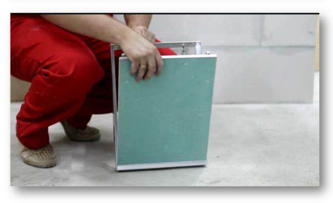
2. Сверлим отверстия для крепления по периметру рамы с внешней стороны на расстоянии 10-15 см от углов.
