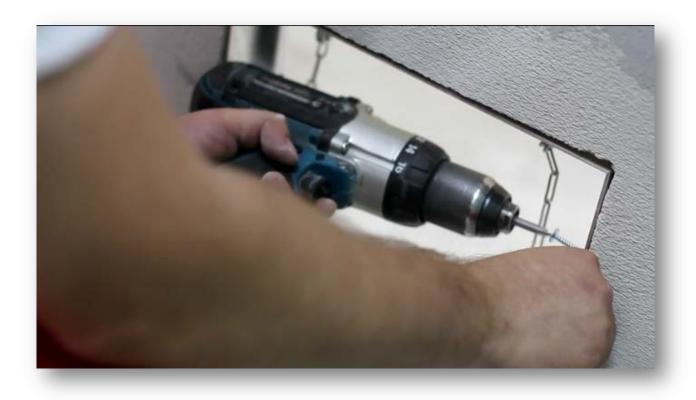
Редко бывает так, что проем для установки люка подготовлен идеально. Нормальная ситуация, когда в процессе инсталляции между ребрами проема и рамой остаются зазоры. Они устраняются в процессе отделочных работ. Важно не перетянуть саморезы!
