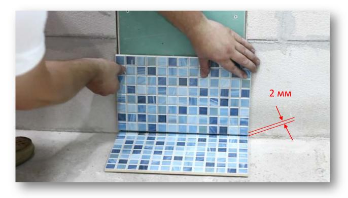
Лучшие варианты клея - клей для плитки либо "жидкие гвозди". Ни в коем случае нельзя клеить плитку на дверь люка на силиконовый герметик! Герметик эластичен, при высыхании пружинит, это приводит к тому, что высыпается затирка между плитками.
