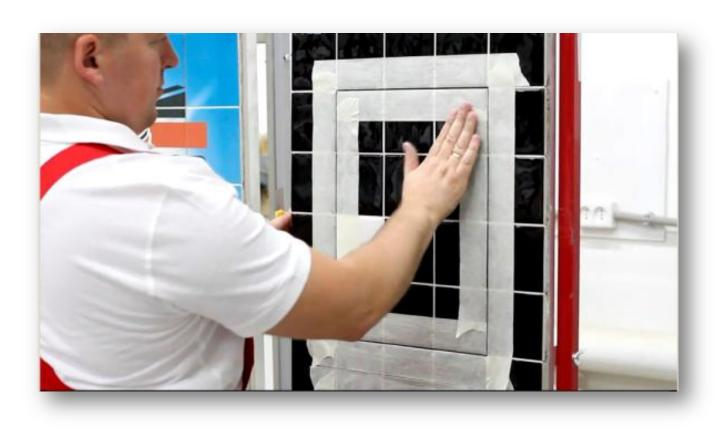
Силиконовый герметик наносится вовнутрь зазора по периметру двери люка слоем 1-1,5 мм.
