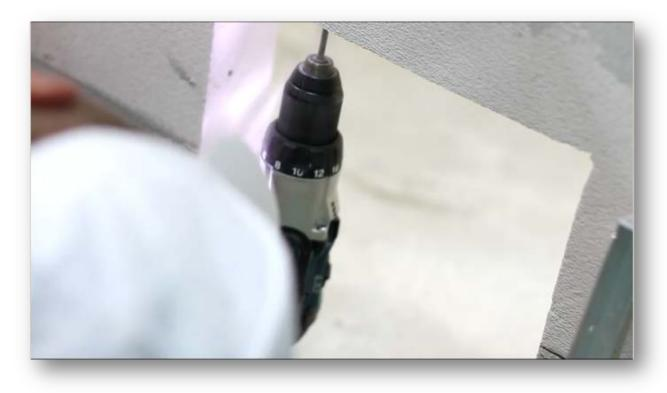
5. Забиваем дюбели в отверстия, просверленные в ребрах проема.
