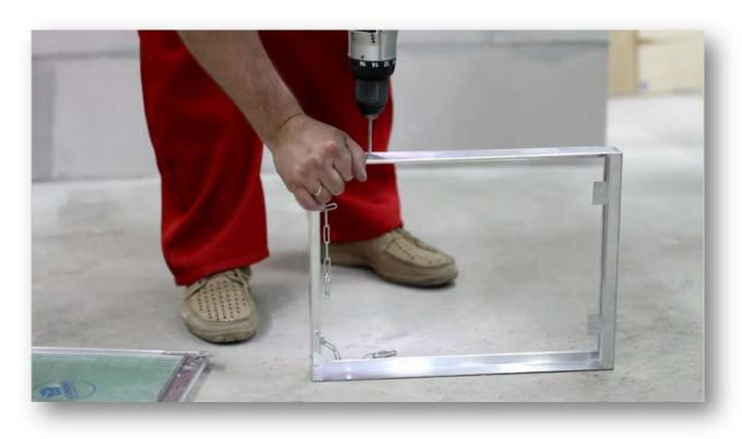
3. Помещаем раму люка в проем, таким образом, чтобы внешнее ребро рамы было заподлицо с плоскостью стены, на которой будут отделочные материалы.
