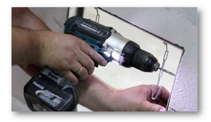
Через готовые отверстия в раме люка сверлим метки в ребрах проема для последующего крепления люка.
