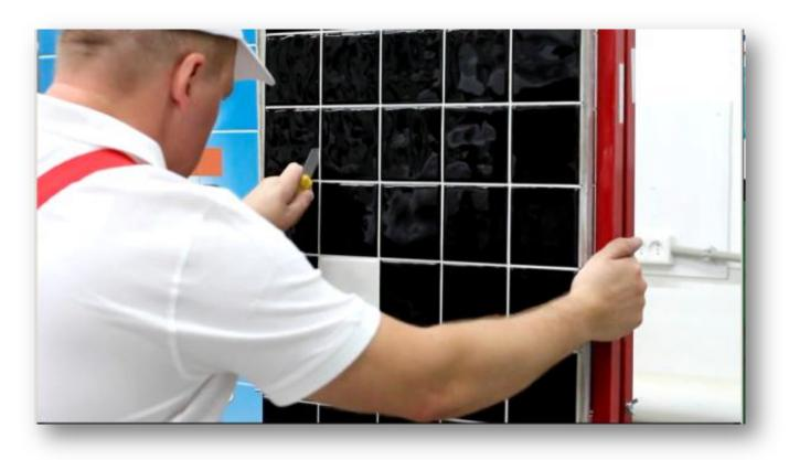
Открыть дверцу и удалить излишки герметика отовсюду, кроме боковых кромок плитки.
