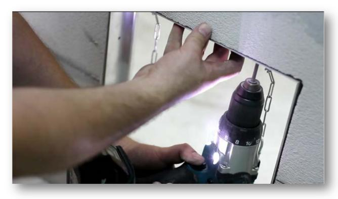
4. Вынимаем раму из проема. По нанесенным меткам сверлим отверстия в ребрах проема.
