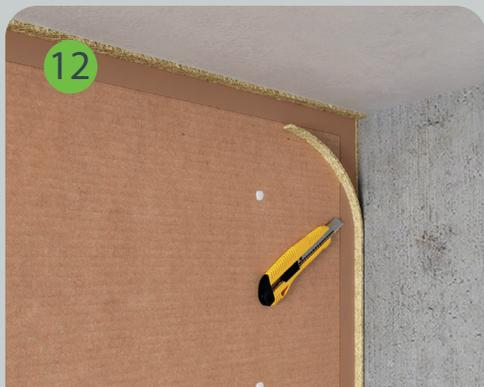
После установки звукоизоляционных панелей SoundGuard ЭкоЗвукоИзол излишки виброакустической подложки SoundGuard VibroRoll удаляются.
