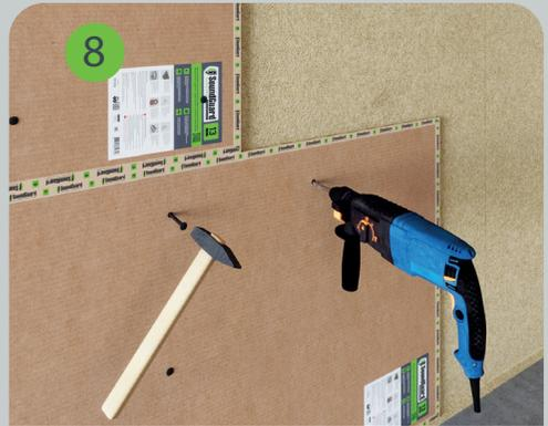
Акустические дюбель-гвозди забиваются в предварительно просверленные (снаружи панели) отверстия в стене и утапливаются в теле панели на 1 мм. На одну звукоизоляционную панель требуется не менее 12 дюбель-гвоздей SoundGuard DA-P.
