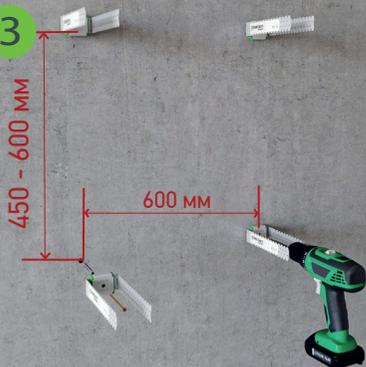
Крепятся виброизоляционные подвесы SoundGuard Vibro М с помощью дюбелей SoundGuard DR 6x60 и саморезов SoundGuard УН 4x80.
