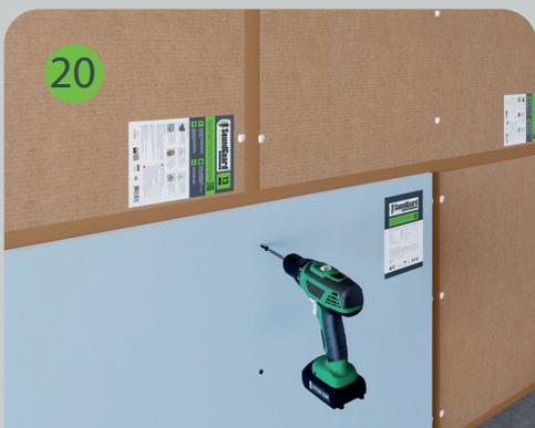
Звукоизоляционный гипсокартон SoundGuard Gipsophon монтируется без зазоров между листами и крепится к профилю саморезами SoundGuard XTN 3,9x41. Расход саморезов составляет не менее 17 шт./м<sup>2</sup>.
