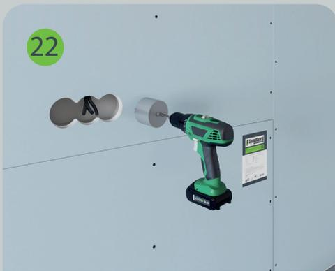
После монтажа звукоизоляционного гипсокартона SoundGuard Gipsoson в нем коронкой просверливается отверстие в месте установки подрозетника.
