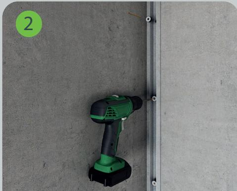
Направляющий профиль крепится через виброкомпенсирующие шайбы SoundGuard ВиброШайба 10x19 с шагом 600 мм с помощью дюбелей SoundGuard DR 6x60 и саморезов SoundGuard УН 4x80\* через просверленные отверстия в профиле.
