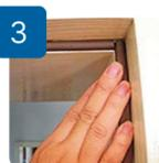
На углах створки окна/двери уплотнитель нужно подрезать под углом 90°. Обрезать уплотнитель нужно немного с запасом, так как он эластичен и легко сжимается.
