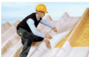
Установка пароизоляционной пленки при ремонте кровли снаружи
