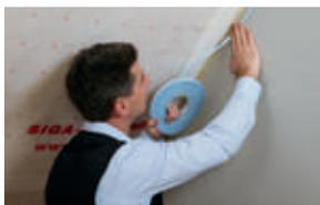
Соединение пароизоляционной пленки с монолитными стенами
