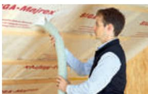
Установка пароизоляционной пленки для задувной теплоизоляции
