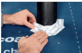
**Врезка в подкровельную мембрану**
