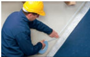
**Соединение подкровельной мембраны с монолитными стенами**
