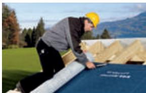
**Установка подкровельной мембраны**
