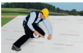
Установка пароизоляционной пленки для изоляции поверх стропил
