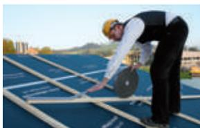
**Установка ленты для изоляции гвоздей**
