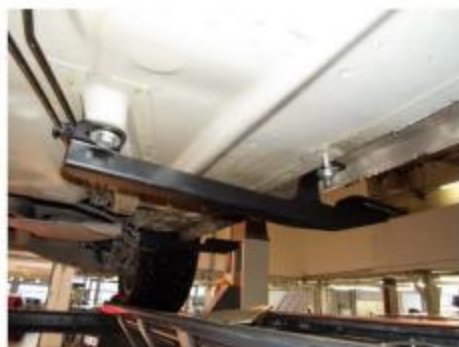
Рис.5 Установка среднего кронштейна
