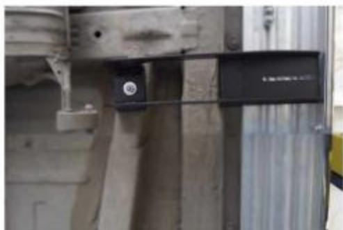
Рис.6 Установка среднего кронштейна
