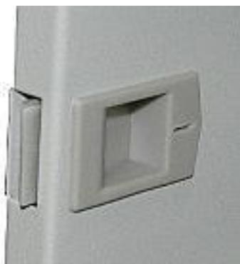
Установить боковые стенки, используя пружинный пластиковый фиксатор как защелку
