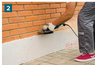
Для монтажа цокольной планки, в стене, выше цоколя на 2-5 см, прорезьте штрбу для герметичной установки планки. Глубина пропила - 1 см.
