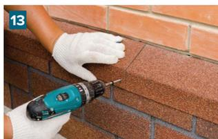
Верхнюю часть планки вставьте в заранее подготовленную штробу, в нижней части зафиксируйте планку с помощью саморезов с шагом 300 мм.
