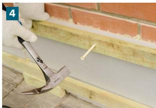
Для устройства обрешетки используйте бруски сечением 20\*40 мм. Расстояние между брусками горизонтальной обрешетки должно составлять не более 300 мм. Крепление - дюбель минимум 120 мм.
