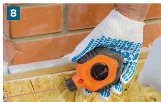
Отметьте точку на высоту одной плитки от уровня отмостки и отмерьте расстояние от верхней части цоколя до этой точки. Отмерьте это же расстояние на другом конце цоколя и соедините точки в направляющую линию с помощью шнура-отбивки.
