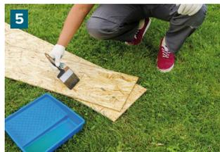
Перед установкой сплошного настила обработайте плиты (доски) полимерной либо битумной обмазочной гидроизоляцией на высоту не менее 300 мм от уровня отмоксти.
