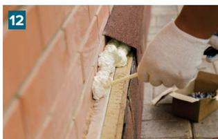
Пространство между теплоизоляцией и планкой заполните монтажной пеной с минимальным вторичным расширением.
