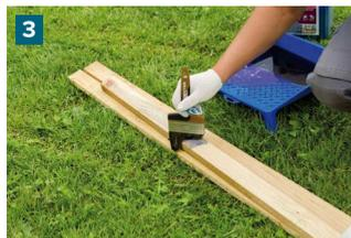
Перед установкой обрешетки обработайте бруски антисептиком для древесины. Нанесите его в 2-3 слоя с промежуточными сушками 20-30 минут. При погружении выдержите 5-10 минут.
