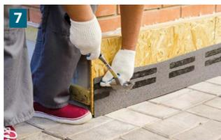
Стартовую полосу сделайте из рядовой плитки, обрезав лепестки. Смонтируйте стартовую полосу таким образом, чтобы она была выровнена относительно отмостки. Крепление на 11 оцинкованных гвоздей с широкой шляпкой: 3 сверху, 8 снизу.
