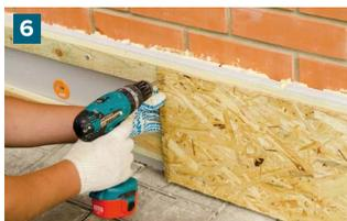
В качестве сплошного настила используйте ОСП-3, либо фанеру ФСФ (повышенной влагостойкости) толщиной не менее 9 мм, обрезную или шпунтованную доску с относительной влажностью не более 20%.
