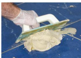
Сразу же после укладки мозаики или спустя некоторое время, в зависимости от условий, заполнить швы приготовленным составом **STARLIKE**, используя специальный резиновый шпатель (1), выполняя движения по диагонали относительно швов, удаляя излишки **STARLIKE** тем же шпательем.
