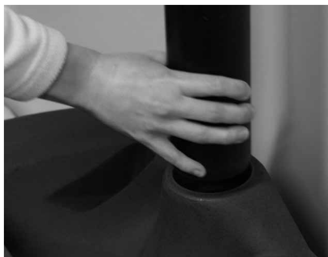
3. Отсоединение вентиляционной трубы.
