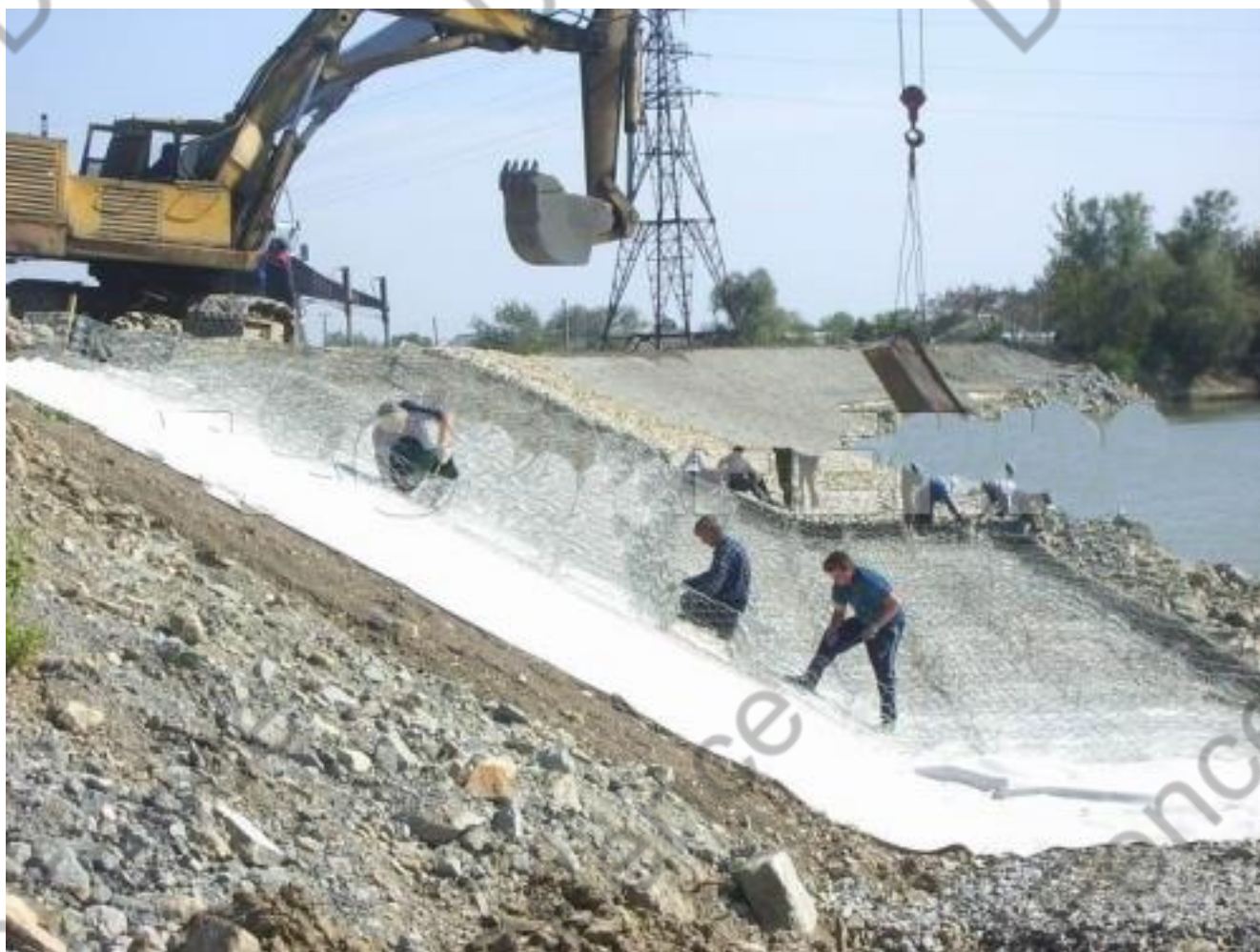
Рисунок 20. Монтаж матрасно-тюфячных габионов на наклонную поверхность с подложкой из геотекстиля.
