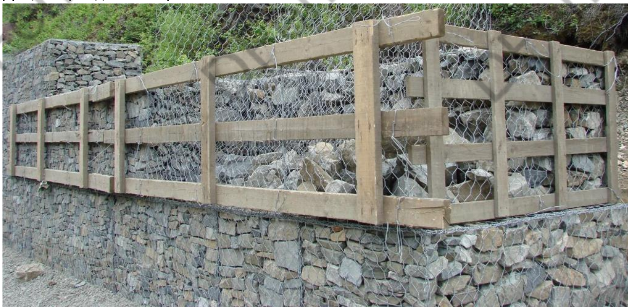
Рисунок 12. Опалубочное ограждение лицевой части габиона.
