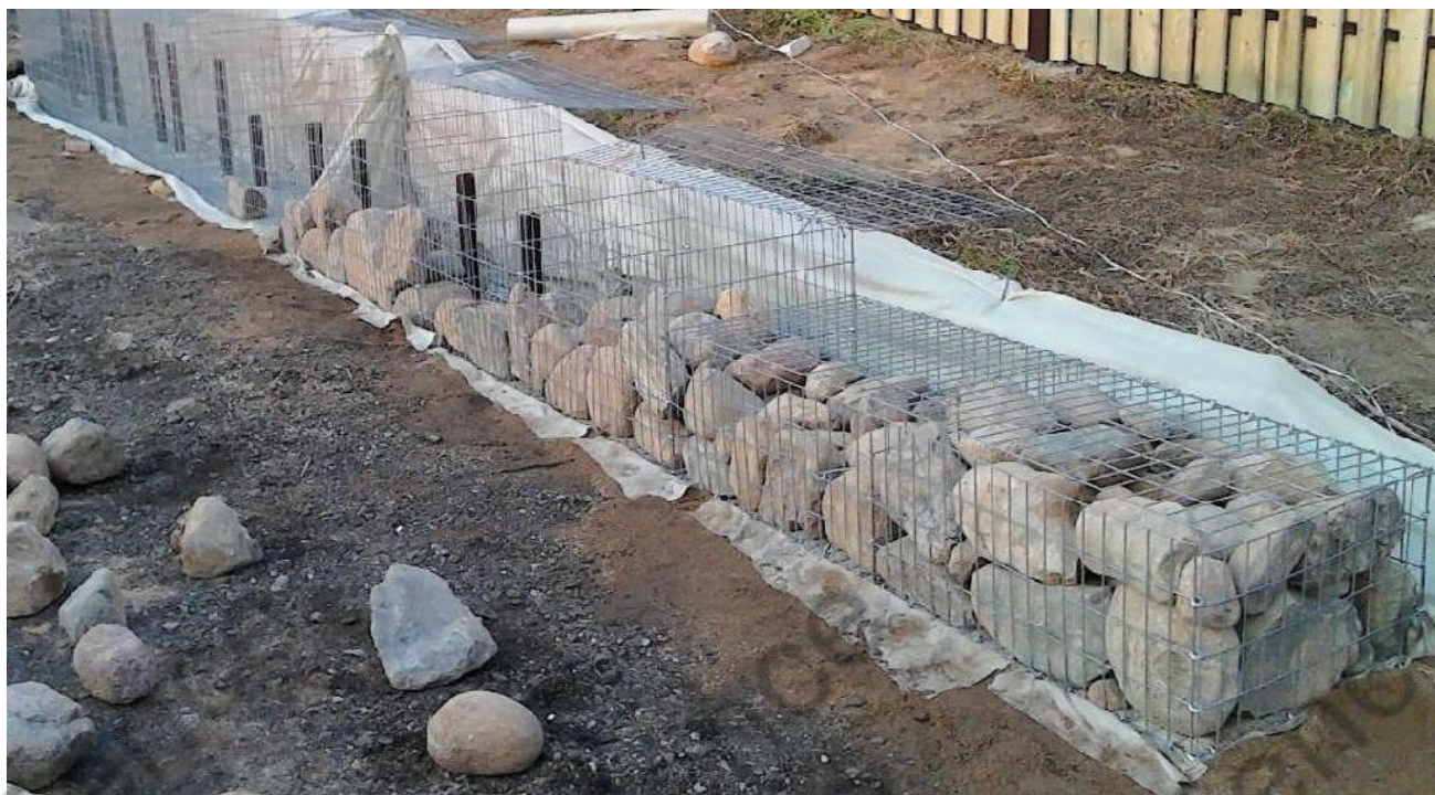
Рисунок 6. Монтаж подпорной стенки с поддерживающими столбами.
