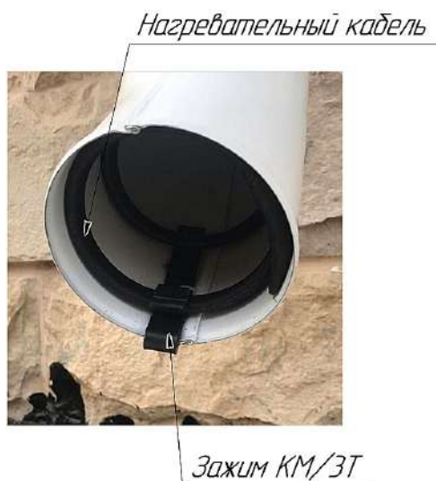
Рис. 4 (Крепление нагревательного кабеля с использованием зажима KM/3T, сливное колено)
