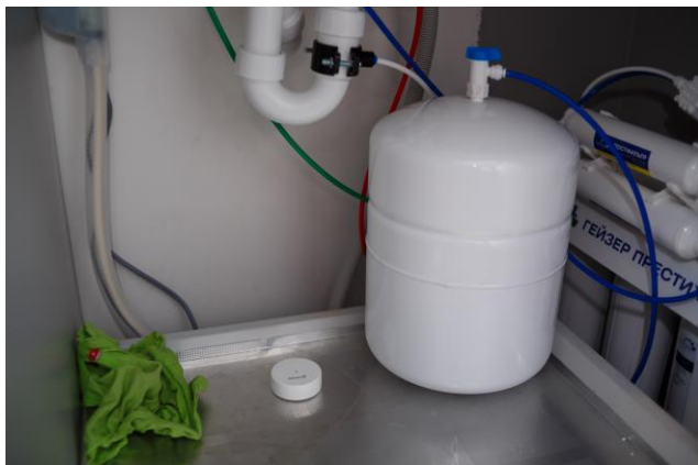
Рисунок 19 – Варианты установки датчиков протечки и движения*
