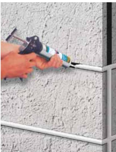
TeKaflx MS 15 для строительства – однокомпонентная эластичная уплотнительная масса на основе гибридного MS полимера, предназначенная для уплотнения деформационных швов в строительстве. Не вредит окружающей среде.
