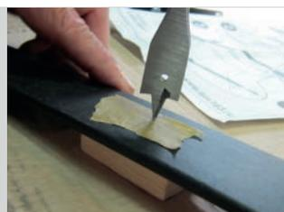
**ШАГ 4.** Приклейте защитную пленку на места под кронштейны в жёлобе. Установите кронштейны на свои места. Скрепите кронштейны между собой винтами М5.
