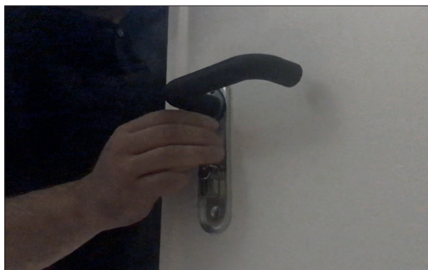
7. Установить второй винт M5x55 мм со втулкой M5x40 мм. Отверстие над цилиндром. Таким образом нажимной механизм будет притянут к полотну.
