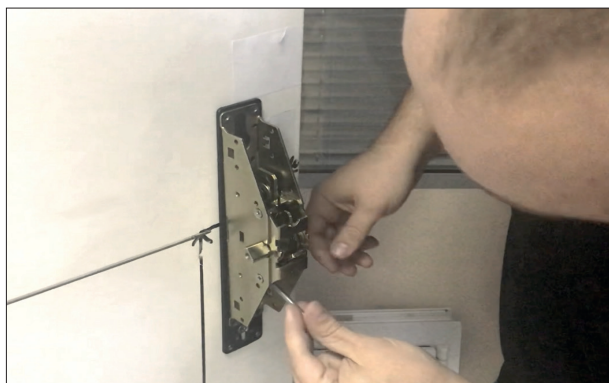
7. Установить второй винт M5x55 мм со втулкой M5x40 мм. Отверстие над цилиндром. Таким образом нажимной механизм будет притянут к полотну.
