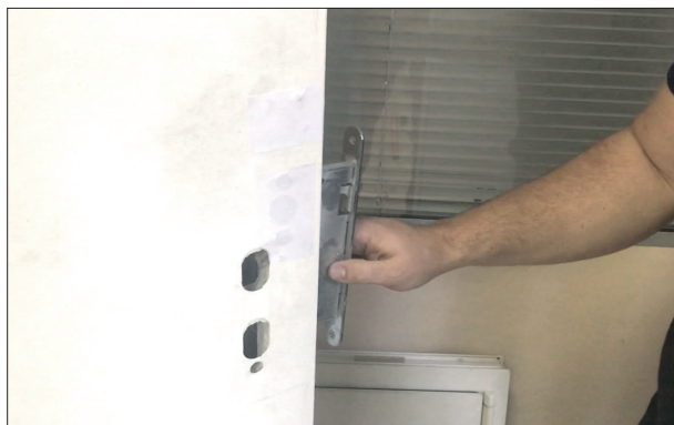
1. Установить замок с функцией «антипаника».
