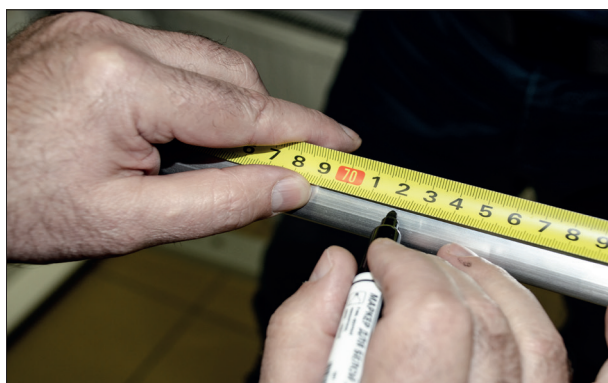
14. Прибавить к измеренному 30 мм и отрезать балку. В нашем случае длина балки составляет 720 мм. Отрезать балку.
