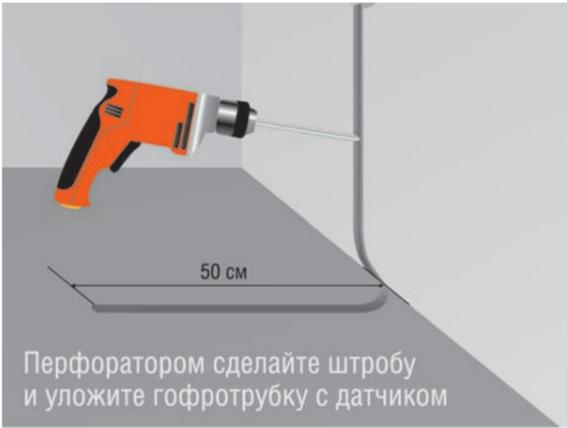
6.3 Чтобы обеспечить свободное перемещение термодатчика в трубке (возможность замены в процессе эксплуатации), рекомендуем при переходе от стены к полу выполнять два больших радиуса изгиба трубки в двух плоскостях.
