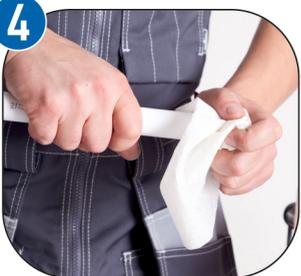
4 Обезжирить зону сварки на конце трубы
