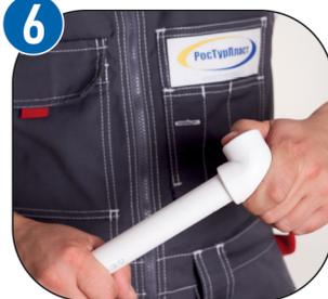
6 Одновременно снять трубу и фитинг с насадок и выполнить сварку, вставив разогретую трубу в разогретый фитинг. Продержать детали около 5 секунд
