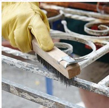
ручная очистка (абразивный ручной инструмент), очистка с помощью химических растворов.
