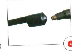
Одеть оконцеватель на кабель и начать усадку с его верхнего конца.
