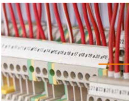
DEK/WS: Маркировка для клемм – напечатал, установил – готово
