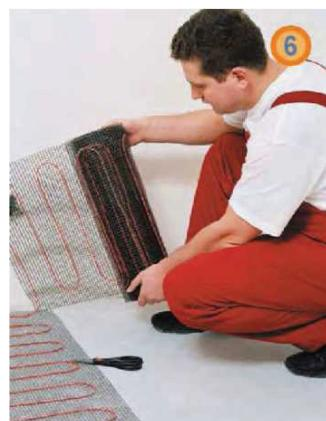
5. Разложить нагревательный мат по всей поверхности пола, обходя трубы и участки, предназначенные для ванных, шкафов и т.п. (разрешается укладывать мат под местами установки подвесных шкафов, умывальников и т.д.). Для обхода препятствий разрезать пластиковую сетку, не повреждая при этом греющий кабель (рис. 6).
