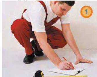
1. Составить чертеж обогреваемой площади, с указанием расположения нагревательных матов, концевой и соединительной муфт, датчика температуры и места подключения к электрической сети. При повреждении греющего кабеля в процессе укладки или в процессе строительных работ это значительно облегчит поиск места повреждения (рис. 1).
