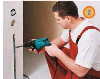
2. В стене и полу прорубить штробу сечением 25 x 25 мм. Она необходима для укладки датчика температуры, холодного соединительного провода и для установки настенной коробки для терморегулятора (рис. 2, 3).
