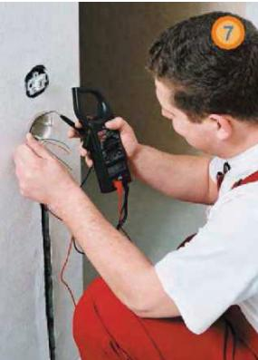
7. После укладки нагревательного мата замерить омическое сопротивление. Омическое сопротивление греющего кабеля должно соответствовать указанному в паспорте на нагревательный мат (рис. 7).
