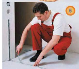
4. Датчик температуры пола поместить в пластмассовую трубку диаметром 20 мм, заглушенную на одном конце для предотвращения попадания внутрь бетона и поместить в штробу, согласно составленному чертежу (рис. 5).
