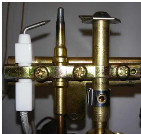
**Термопара** контролирует наличие пламени на запальной горелке
