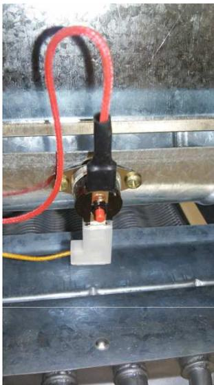
**Датчик тяги** обеспечивает отключение аппарата в случае неполадок в системе удаления продуктов сгорания.
