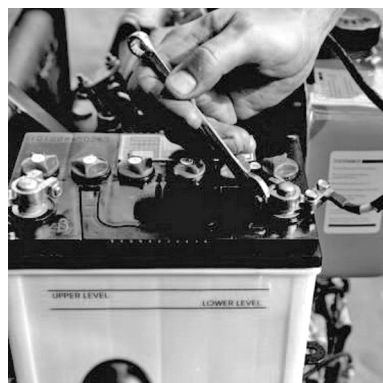
Подсоединение силового кабеля к минусовой клемме АКБ
