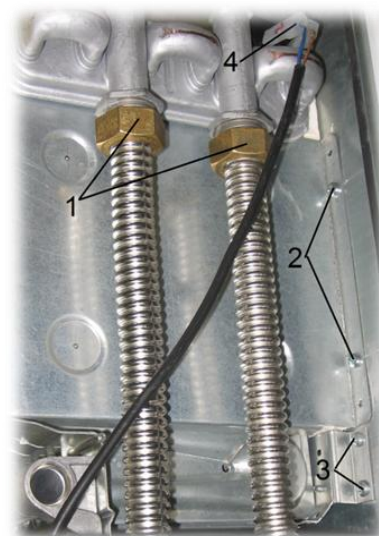
Рис. 15. Демонтаж горелки
