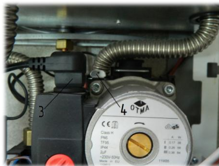
Рис. 17. Демонтаж насоса
