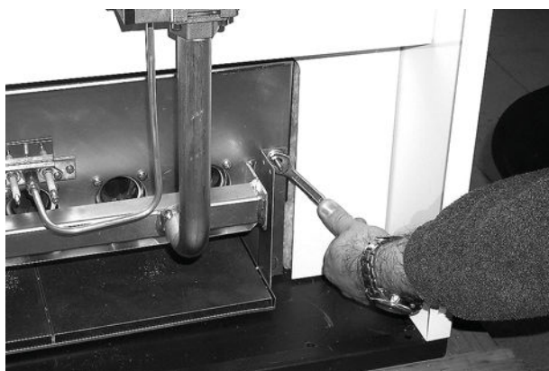
рис. 10 - Развинтите гайки крепления камеры сгорания
