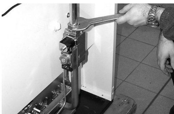
рис. 9 - Открутите гайку крепления газового клапана
