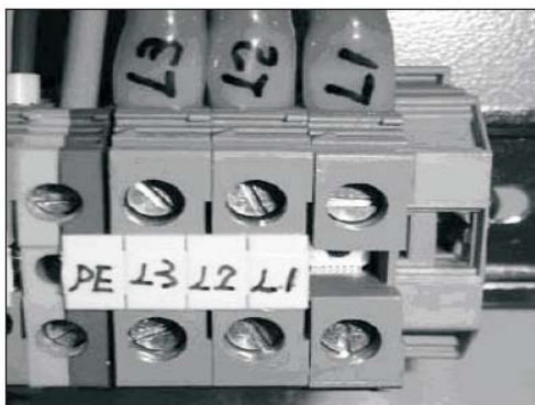
Распределительный блок станка версии "CE"
