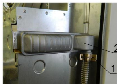
Рис. 23. Демонтаж теплообменника котла «NEVALUX-8230»
