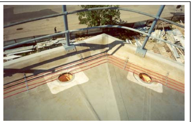
Рис. 5. Монтаж нагревательного кабеля deviflex ™ DTIP-18 на крыше.
