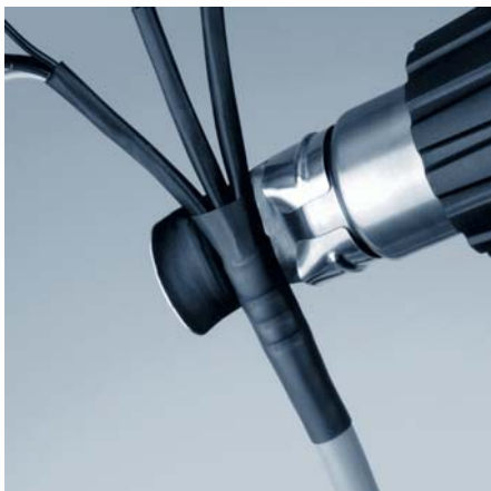
Термоусадка оболочки кабеля
