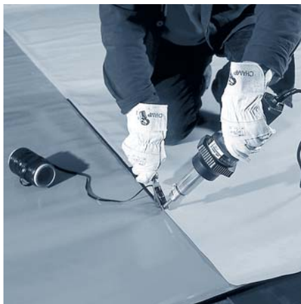
Сварка пластиковой пленки
