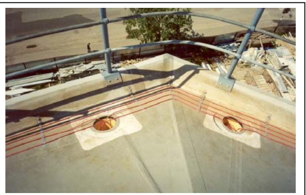
Рис. 5. Монтаж нагревательного кабеля deviflex ™ DTIP-18 на крыше.
