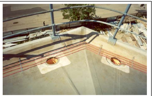
Рис. 5. Монтаж нагревательного кабеля deviflex ™ DTIP-18 на крыше.
