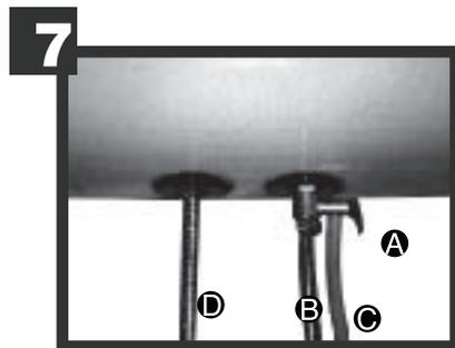
• Подсоедините магистраль холодной воды (В) к нижнему патрубку предохранительного клапана.
