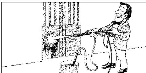
Очищение пескоструйным соплом остатков краски, ржавчины и фасадов. Пескоструйный инжектор со всасывающей насадкой и 3-метровым шлангом из ПВХ и ниппелем ST30.
