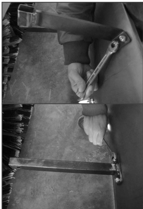
Рис. 2 Установка кронштейнов крепления отвала
