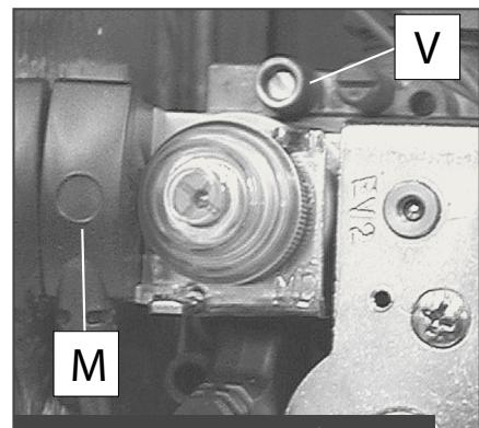
рис. 32 - Точка измерения давления
