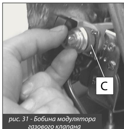
рис. 31 - Бобина модулятора газового клапана
