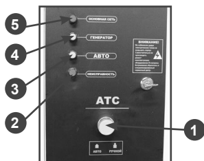
Рис. 11 Контрольная панель блока ATS
