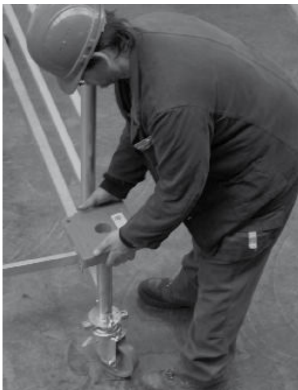
Оснащение траверс балластными грузиками
