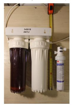
Сравнительные размеры нового фильтра 3М и магистрального фильтра с двумя 10-дюймовыми колбами
