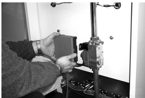
рис. 8 - Снимите блок управления
