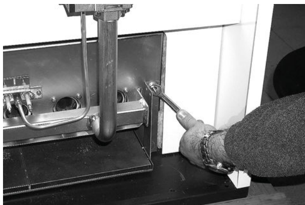
рис. 10 - Развинтите гайки крепления камеры сгорания
