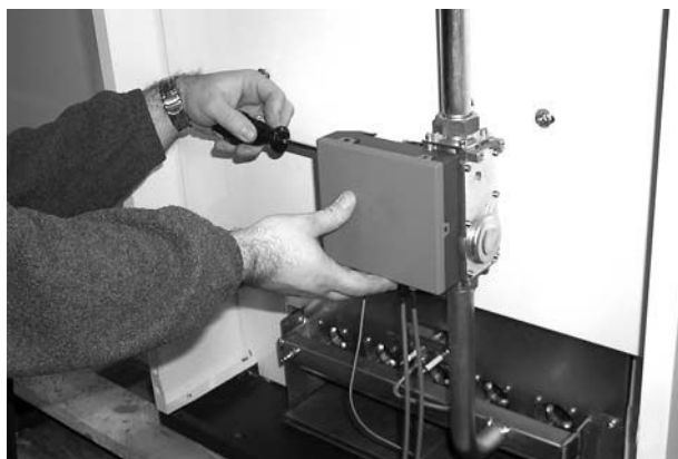
рис. 7 - Открутите два винта крепления блока управления
