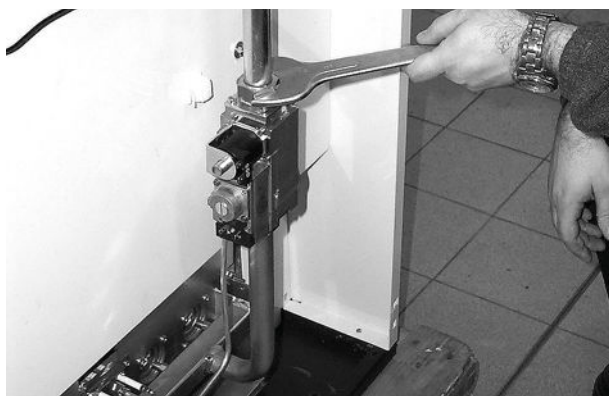
рис. 9 - Открутите гайку крепления газового клапана
