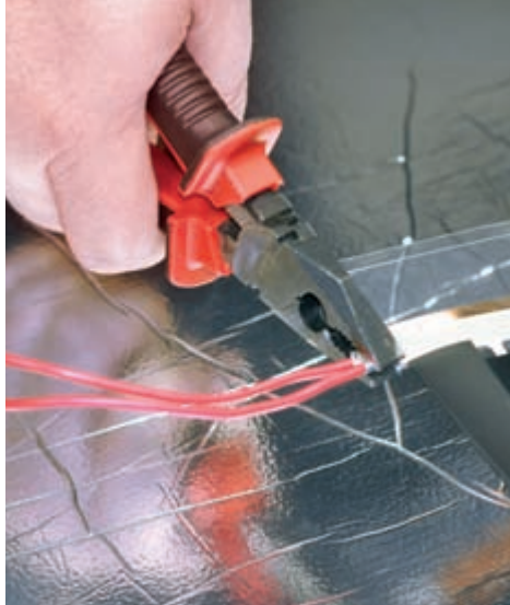
Рис. 16. Надежно зажмите провода в контактном зажиме
