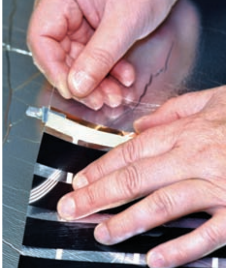
Рис. 8. Установленный на термопленку контактный зажим
