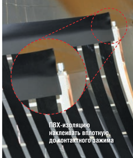
Рис. 11. Наклейка ПВХ изоляции на срез пленки
