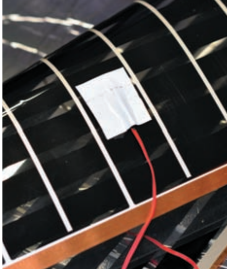
Рис. 25. Установленный и приклеенный датчик температуры пола. Вид снизу термопленки
