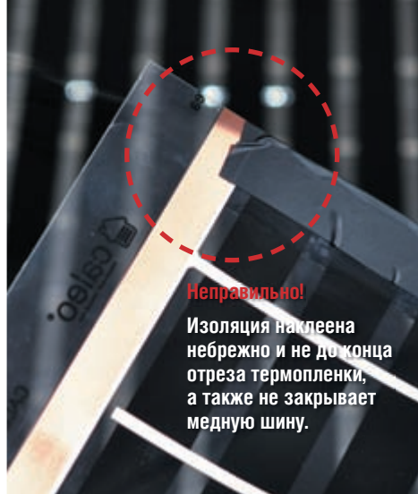
Рис. 14. Пример неправильной установки ПВХ изоляции
