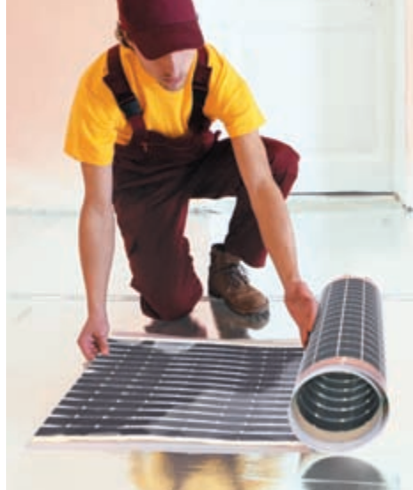
Рис. 6. Раскатывание рулона теплого пола CALEO PLATINUM на теплоотражающем материале
