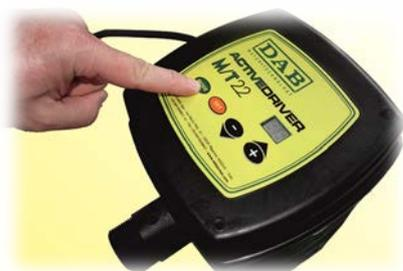
переходим к параметру "GP", это пропорциональный коэффициент ПИД-регулятора, оставляем величину, установленную на заводе, она равна 1,0.
