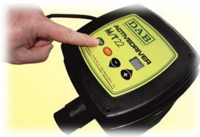
переходим к параметру “Ad”, устанавливаем его “--”.
